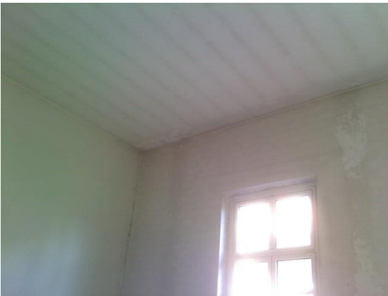
Figura 5: Particolare lato interno P3
